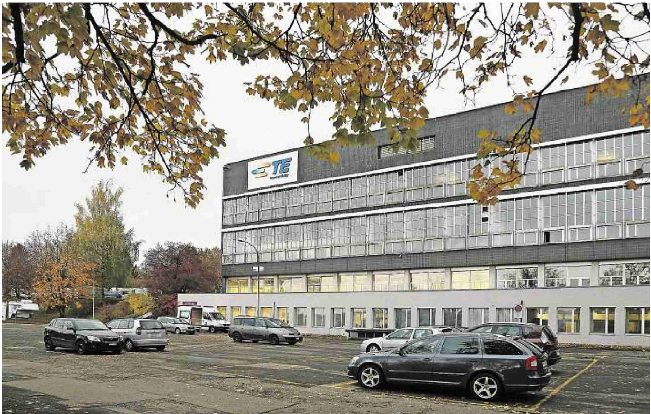
Die Metallwerkstatt der Stiftung Bühl ist derzeit im Au-Parc im Erdgeschoss und im Hochparterre zu Hause. Gaby Schneider
