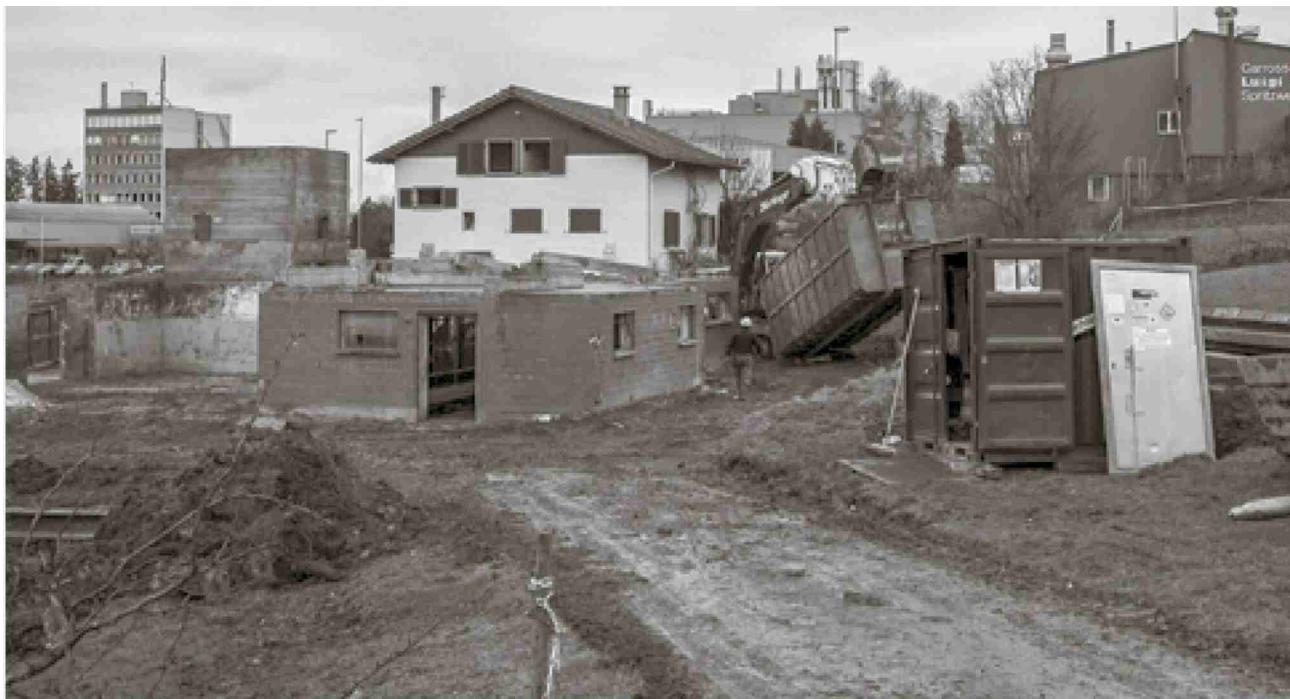
Abbruch des Rütihofs, 2007
