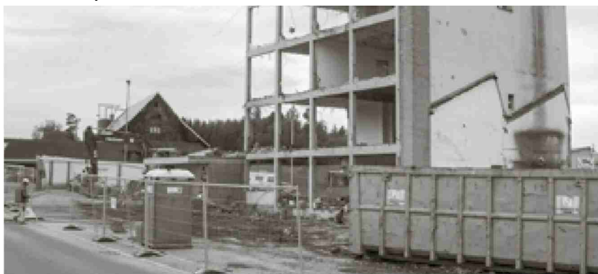
Abbruch der Gebäude der Firma Störi, 2008.
