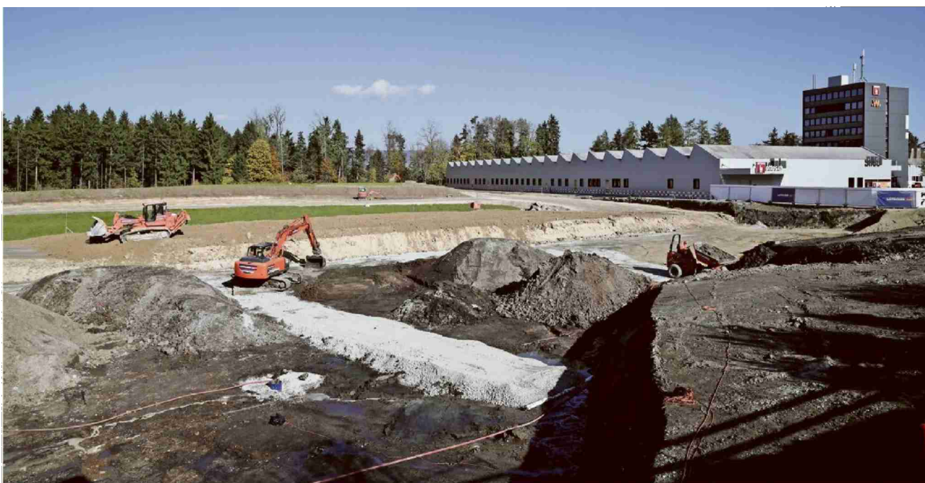
Baufahrzeuge ebnen den Weg für den künftigen Wädenswiler Gewerbe- und Industriepark Werkstadt Zürichsee im Rütihof.
