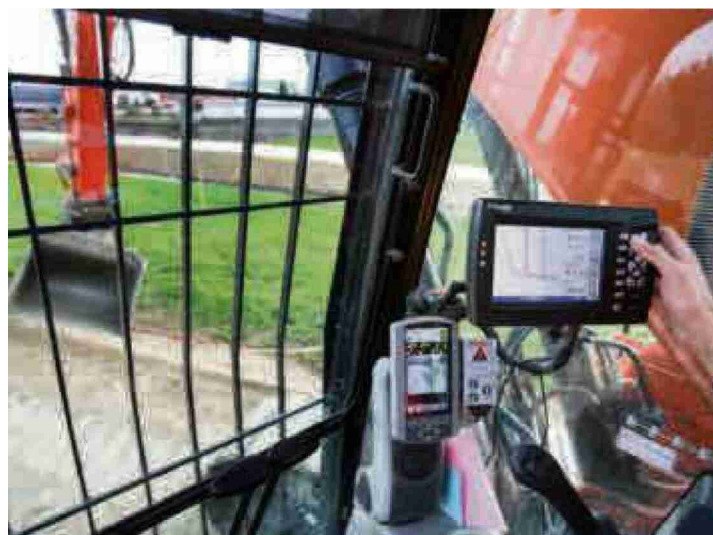
Mithilfe von digitalen Plänen wird auf der Baustelle im Wädenswiler Rütihof zentimetergenau gebaggert.
